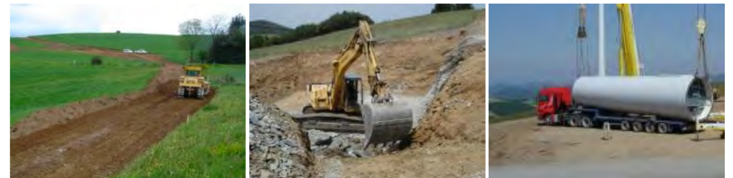
Photographie 136 : Illustration d'un chantier éolien.
